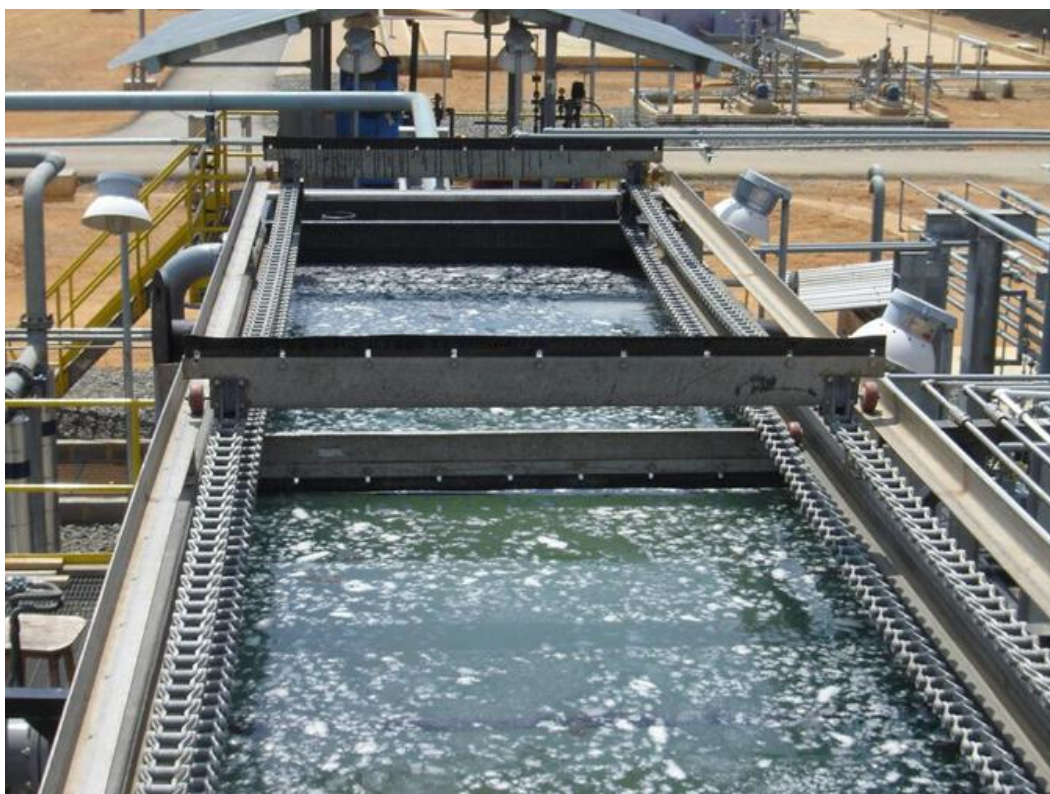
სურათი 11. კოაგულაცია-ფლოტაცია -დალექვის კომბინირებული გამწმენდი სისტემა
