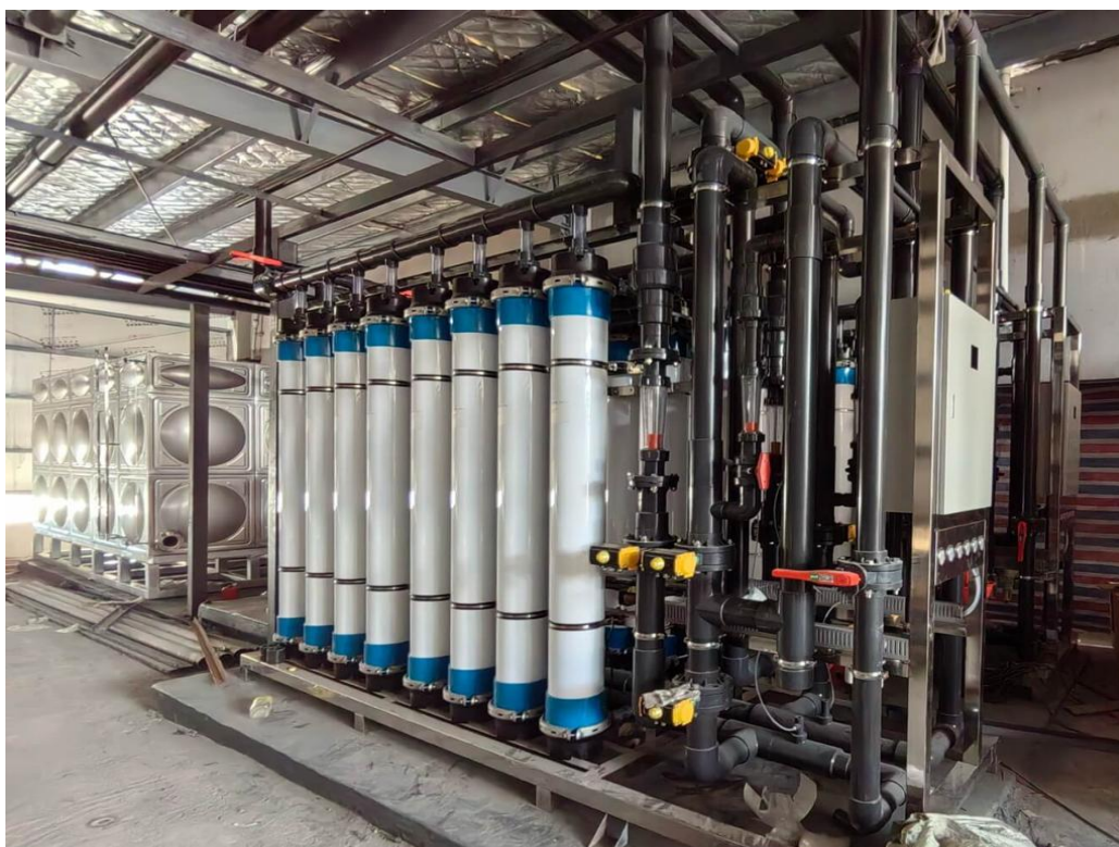
სურათი 13. სამრეწველო ულტრაფილტრაციული წყლის გამწმენდი სისტემა.
